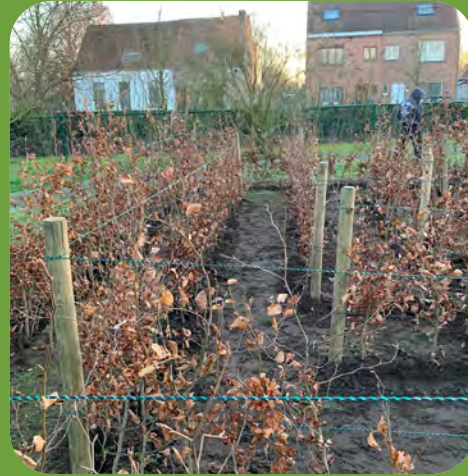
Aanleg van een doolhof in een speeltuin in Evergem
